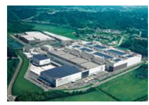
工場の屋上や窓
